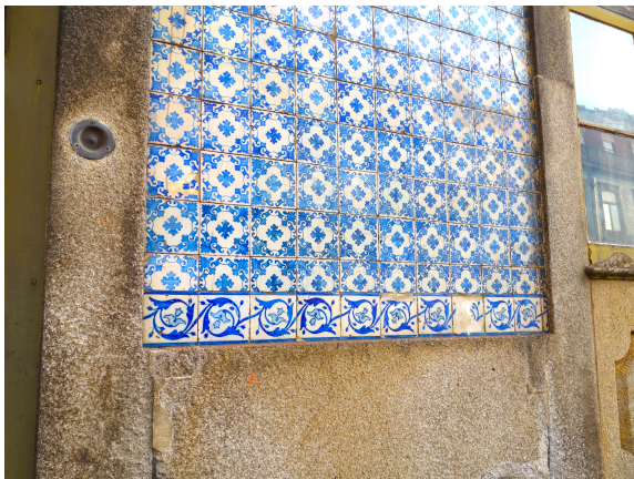
R. da Restauração, 430, Porto
